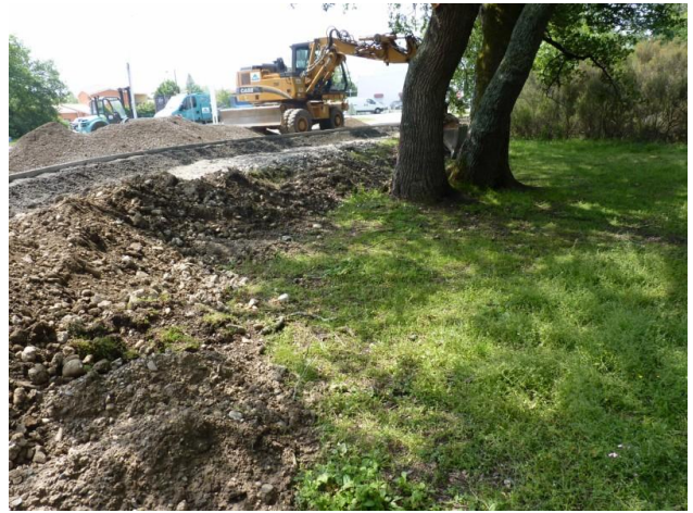
Station suivie depuis 2012 suite à des travaux de voirie à 2 mètres des premiers individus
